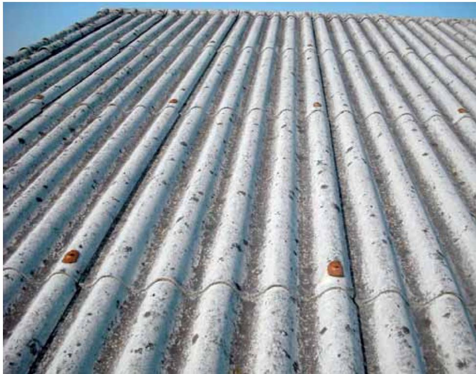
I manufatti d'amianto più diffusi sono le lastre di eternit per la copertura in edilizia. La rimozione avviene dopo il parere favorevole dell'Asl di competenza.
