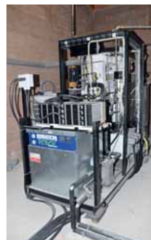
La scuola d'infanzia "11 aprile 1948". Sopra: il cogeneratore alimentato a metano che produce idrogeno.
